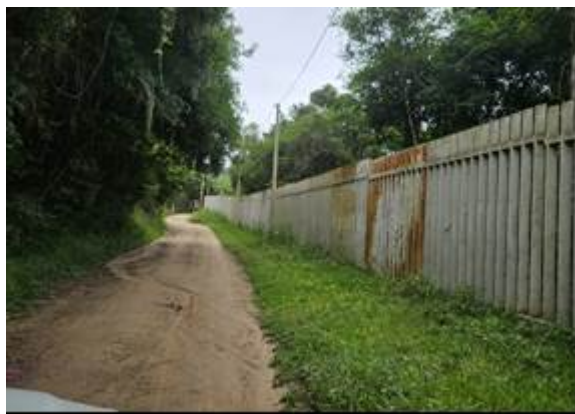
Figura 2. Gradil de concreto frontal.
