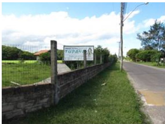
Foto 6. Muro do PNM Tupancy junto a via principal de acesso.
