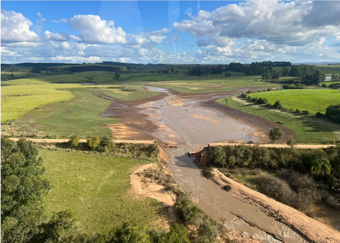
Figura 9: Vista de jusante para montante da barragem, com destaque para a área central de rompimento do maciço (-31,0023° S / -52,6153° W) sob responsabilidade da SDR-RS (Canguçu/RS).
