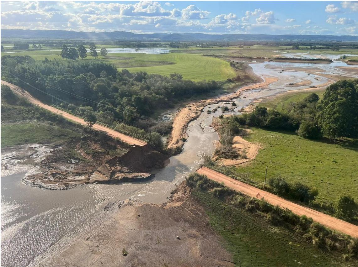
Figura 8: Visão aérea do rompimento das duas barragens em cascata sob responsabilidade da SDR-RS (Canguçu/RS).
