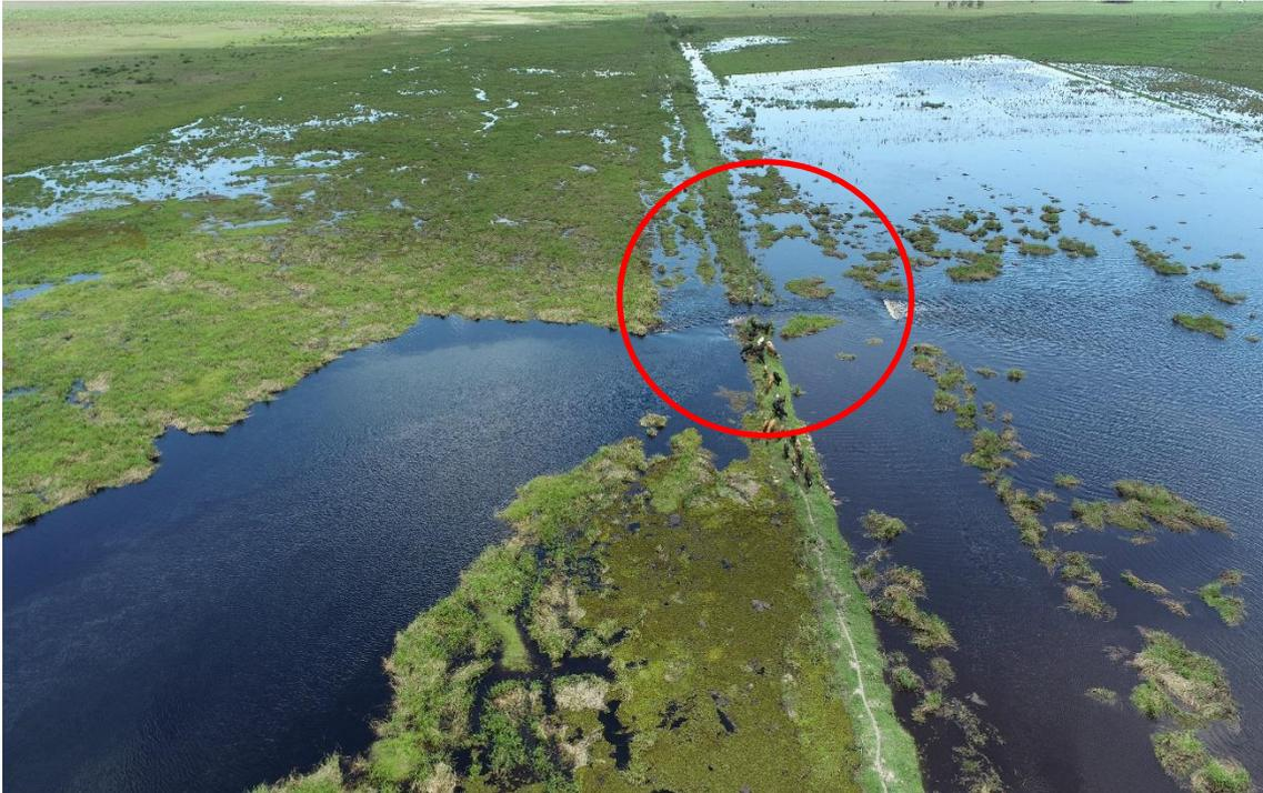
Figura 11: O círculo em vermelho mostra a área de rompimento do maciço lateral em péssimas condições de manutenção.
