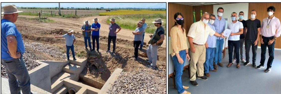
Figura 8: Foto da esquerda demonstrando as obras para execução de dreno de pé e na direita a entrega do PSB da Barragem Capané pelo representante legal do IRGA (Fotos: Divulgação IRGA).
