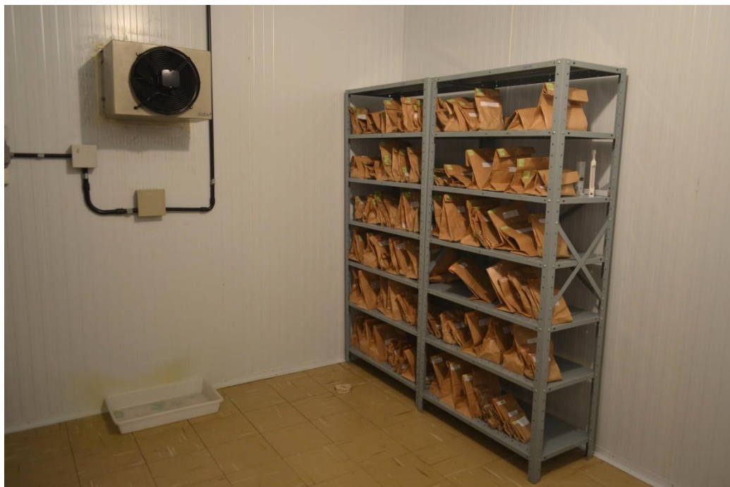
Câmara fria seca (17°C; 45% UR) destinada ao armazenamento de sementes tolerantes à perda de umidade.
