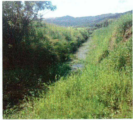
Figura 6. Drenagem da BR-290 junto ao túnel de acesso ao PMMBP.
