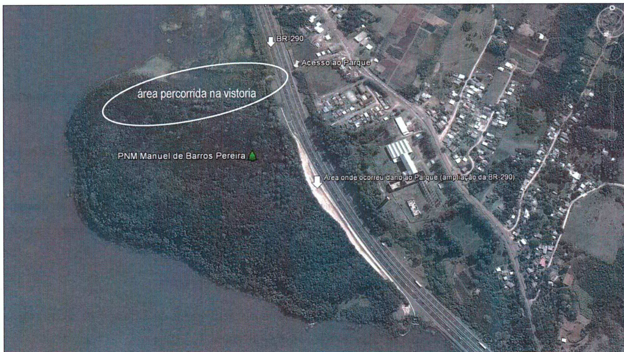
Figura 1. Localização do PM Manuel de Barros Pereira e da área percorrida na vistoria, acesso ao Parque e área em processo erosivo em decorrência da ampliação da rodovia BR-290.
