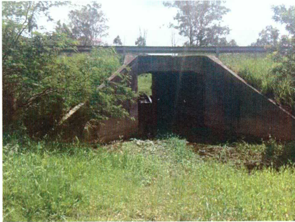
Figura 5. Túnel localizado abaixo do leito da BR-290.
