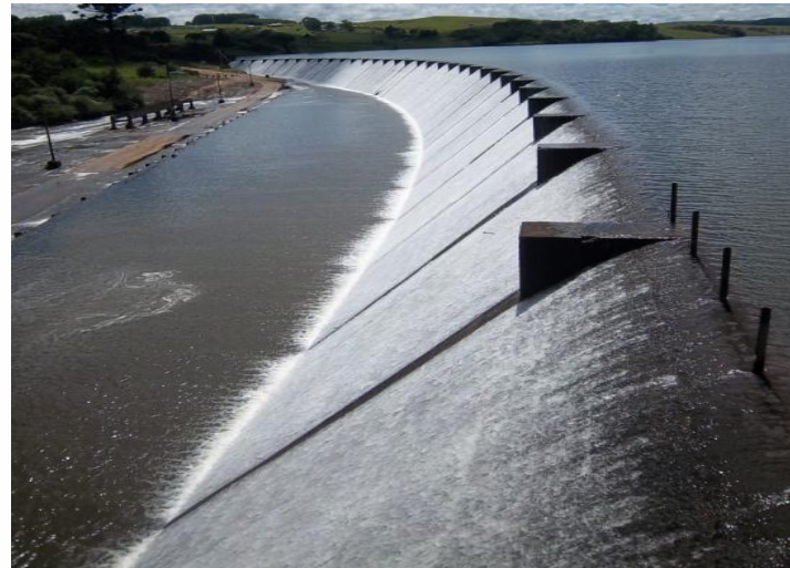
Barragem do Salto - Concreto
