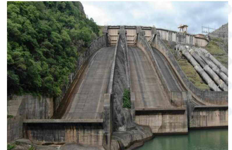
Barragem de Itaúba - Enrocamento
