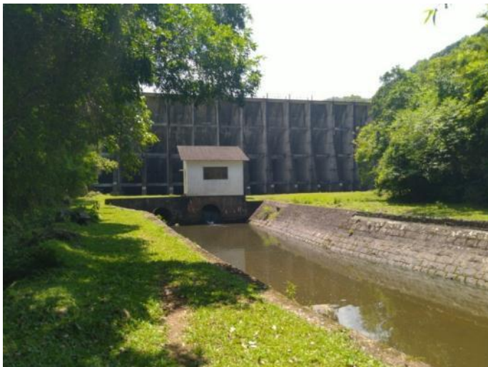
Barragem de Canastra - Contraforte
