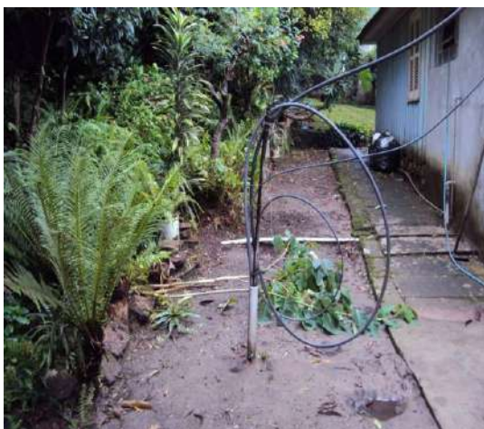
Figura 33 – Trechos de canalização da drenagem.
