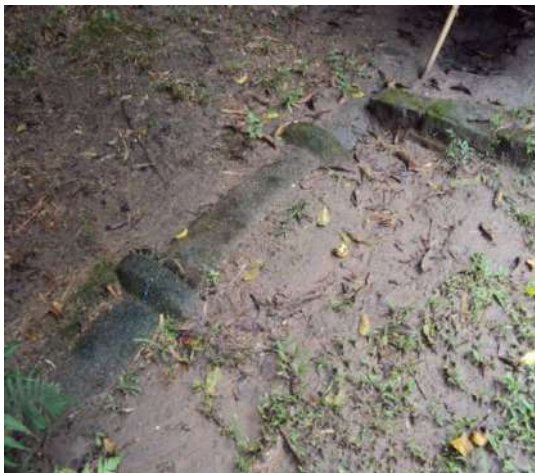
Figura 31 – Trechos de canalização da drenagem.
