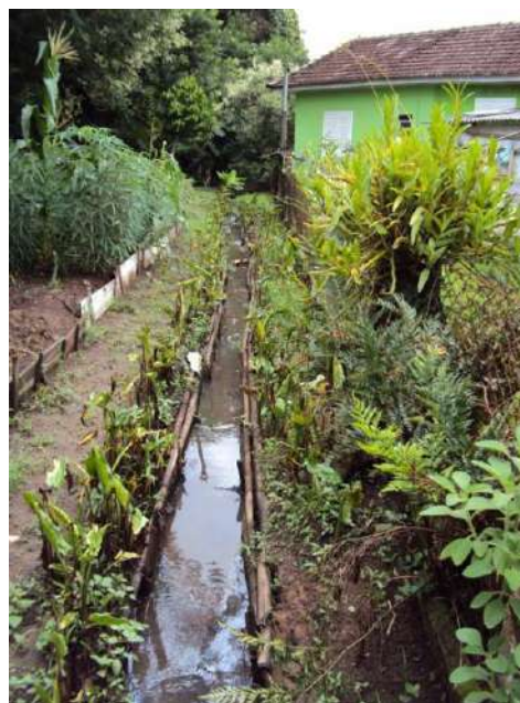
Figura 34 – Trechos de canalização da drenagem.
