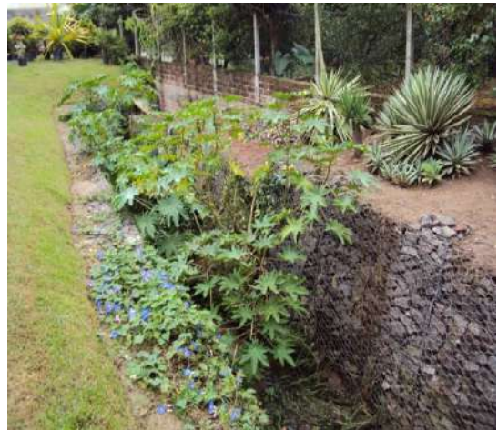
Figura 27 – Continuação da drenagem canalizada atravessando a Rua Barão de Santo Ângelo.
