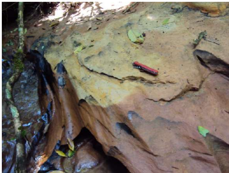
Figura 23 - Contato entre rocha sã e horizonte B.
