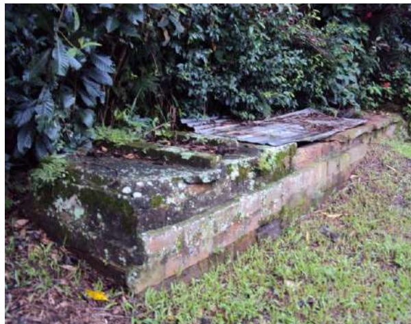
Figura 32 – Trechos de canalização da drenagem.
