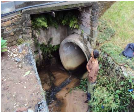
Figura 26 - Drenagem canalizada atravessando a Rua Barão de Santo Ângelo.
