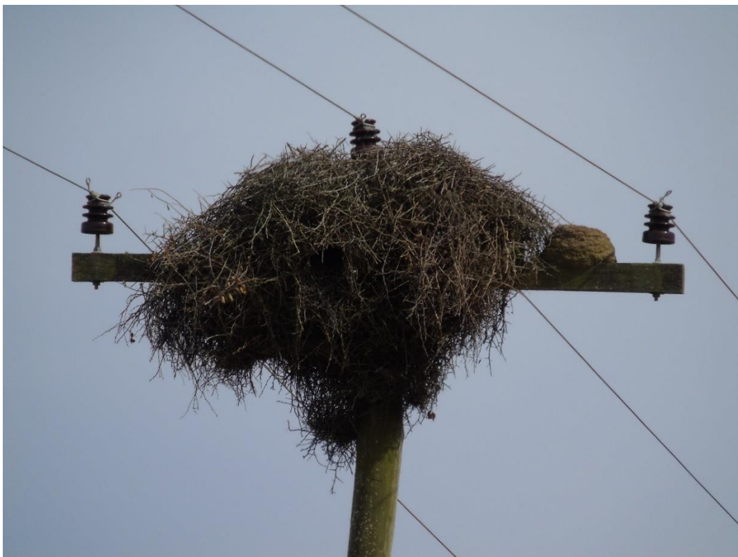
Figura 46 - Rede de distribuição elétrica.
