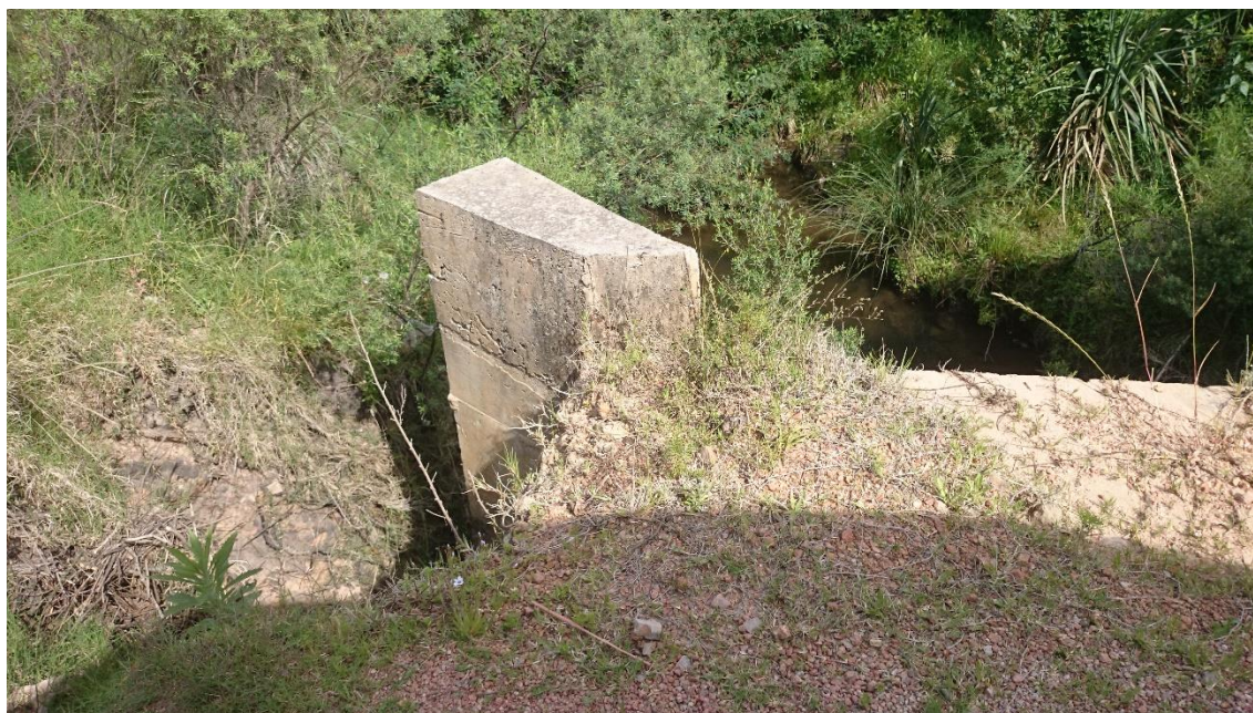
Figura 45 - Estrutura de contenção realizada na ponte sobre o Arroio Candiota.
