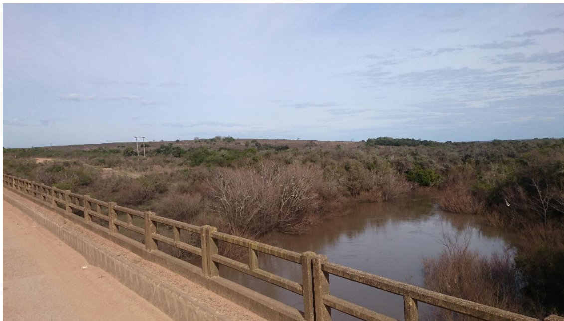
Figura 44 - Ponte sobre o Arroio Candiota.
