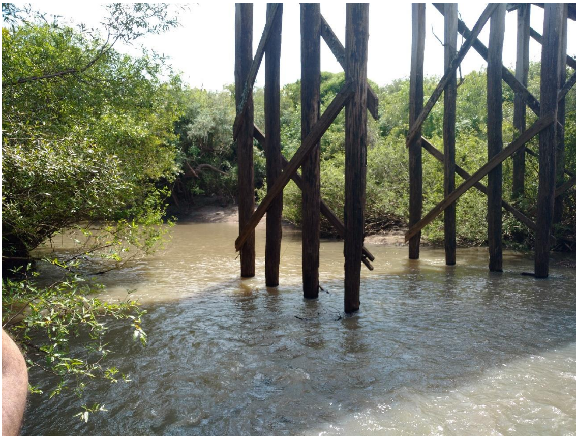
Figura 43 - Ponte de madeira sobre o Rio Jaguarão.
