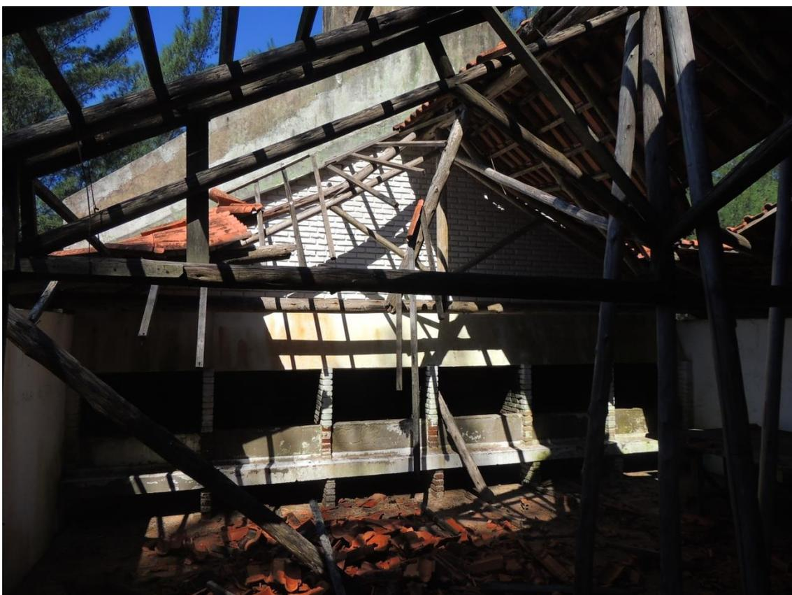
Figura 12 - Estrutura do antigo camping altamente deteriorada.
