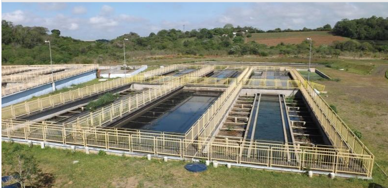
Sistema de recebimento de cargas externas na ETE Glorinha
