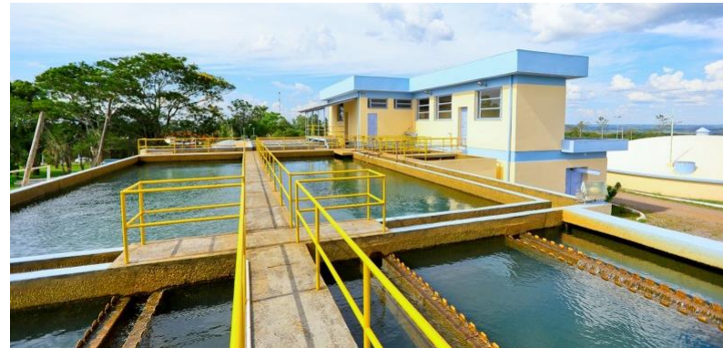
Duplicação da ETA Rio Branco (Canoas)
