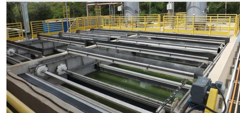
Conclusão da ETE Lorenzi (Santa Maria)
