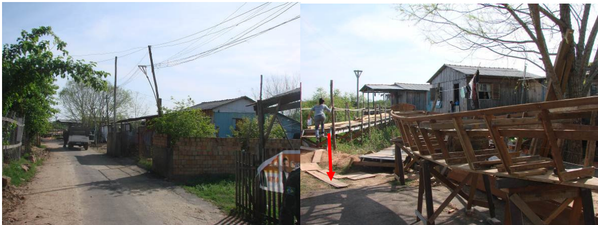
Figura 2.68: Pavimentação do Beco Sossega Leão – ilha da Pintada
