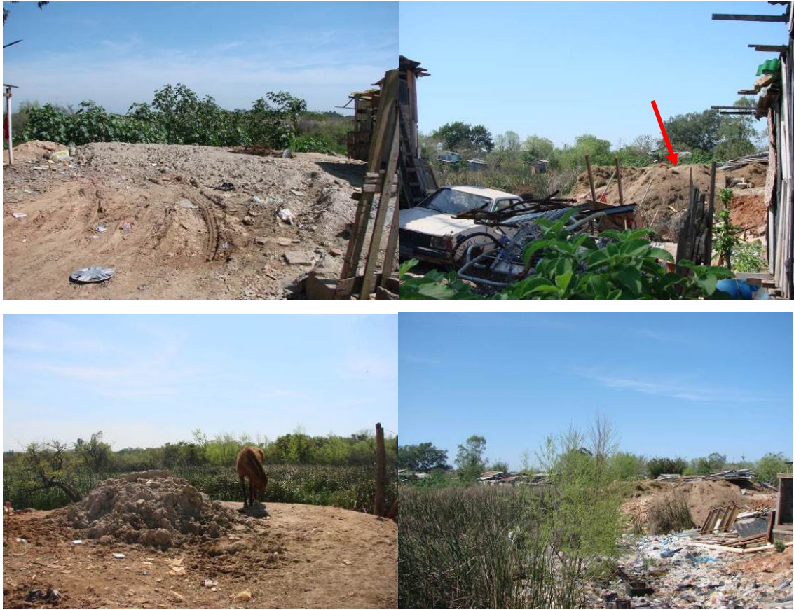
Figura 2.60: Áreas aterradas no Beco 18, no Parque Estadual Delta do Jacuí
