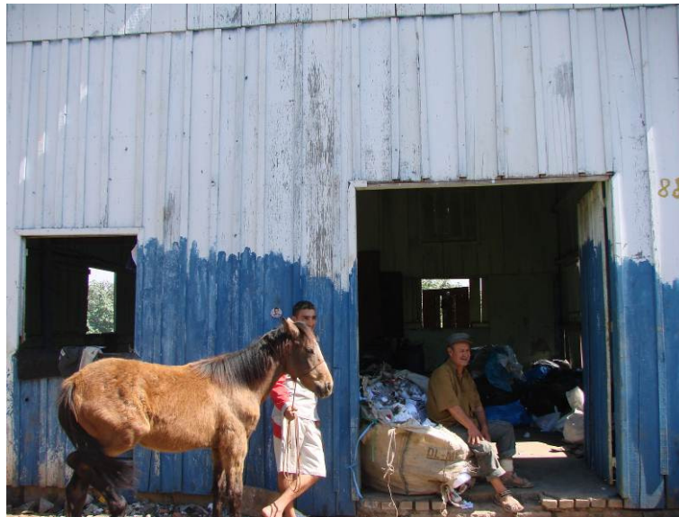
Figura 2.61: Galpão utilizado para o armazenamento e seleção de resíduos sólidos urbanos no Paque Estadual Delta do Jacuí
