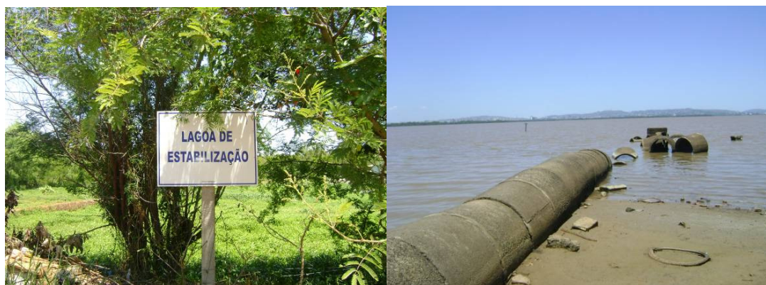
Figura 1.44: Estação de tratamento de efluentes do Grupo Olvebra e despejo final no curso d'água do Bairro Sol Nascente
