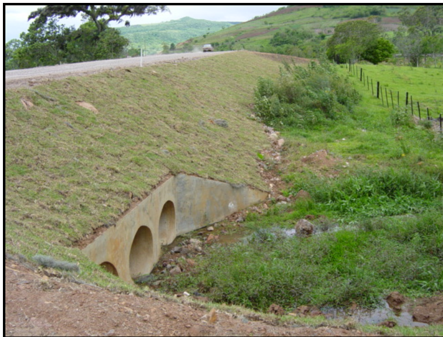
Figura 3.1 Canaletas de bueiros e galerias sob a rodovia.
