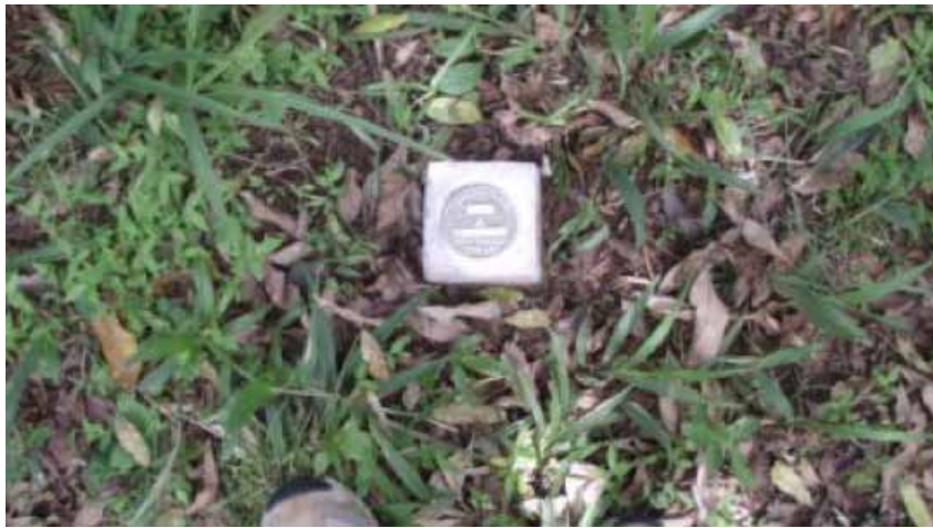
Figura 52 – Marco definitivo de concreto sinalizando limite do Parque
